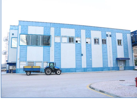
Şekil 13. EnerjiSA Bandırma-I DGKÇS kontrol binası genel görünüş
