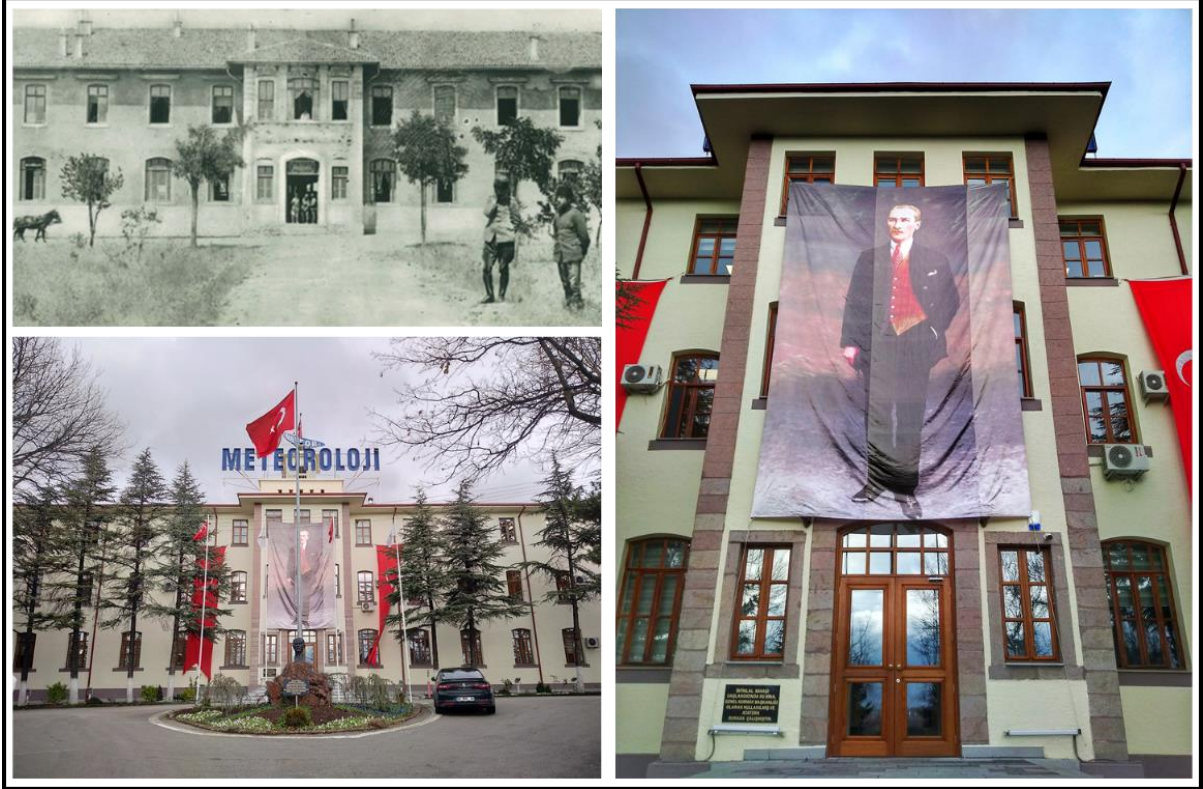
Şekil 9. İki katlı Ziraat Mektebi Binasının sonradan eklenen üçüncü katındaki uyumsuz pencereler (24.12.2019).
