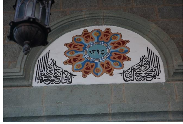
Res. 10. Merkez Büyük Camii Kitabesi
