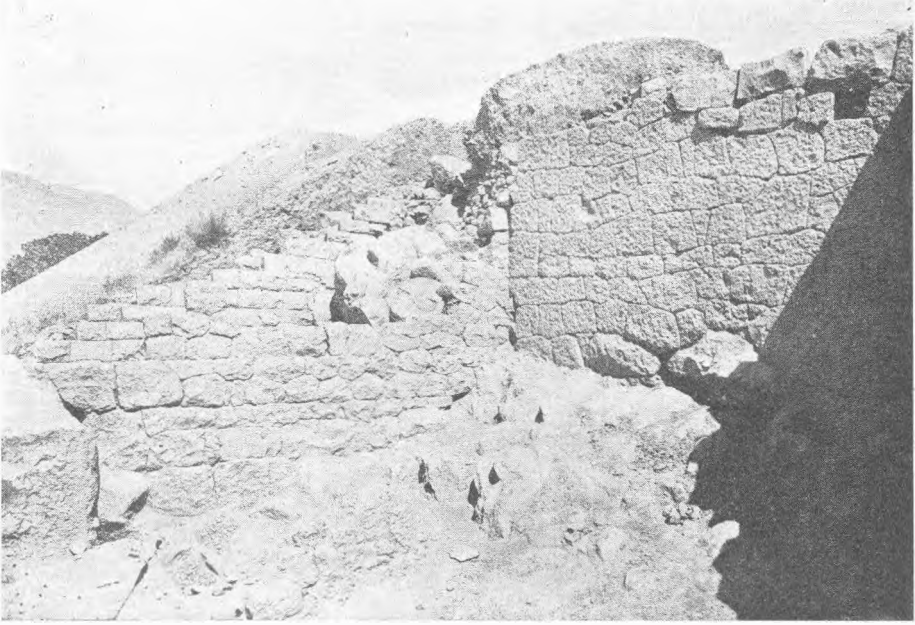
Çok köşeli (Polygonal) duvar. 7 N. lı burç ve son devir istihkâmı dipte
