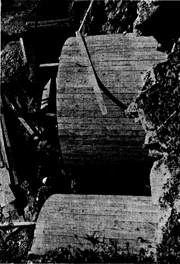
foto 2 Schalung für die neuen Substruktionsgewölbe.
