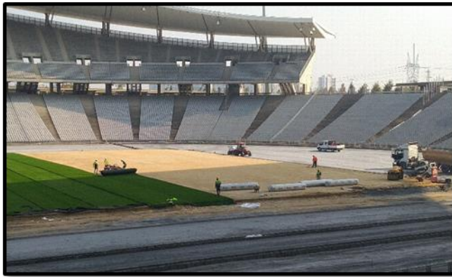
Şekil 4. Atatürk Olimpiyat Stadı Halı tabanlı sistem uygulaması (Hatko hibrit çim)
