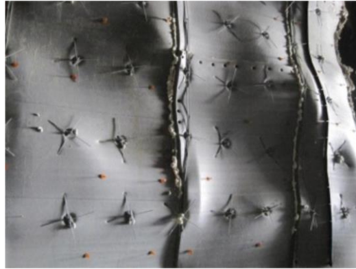
Şekil 12. Monte edilmiş standart drenaj matı [34]
