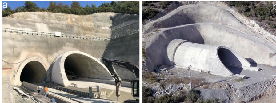
Şekil 16. Tünel giriş-çıkış yapıları (a: 45 derece; b: 33 derece)
