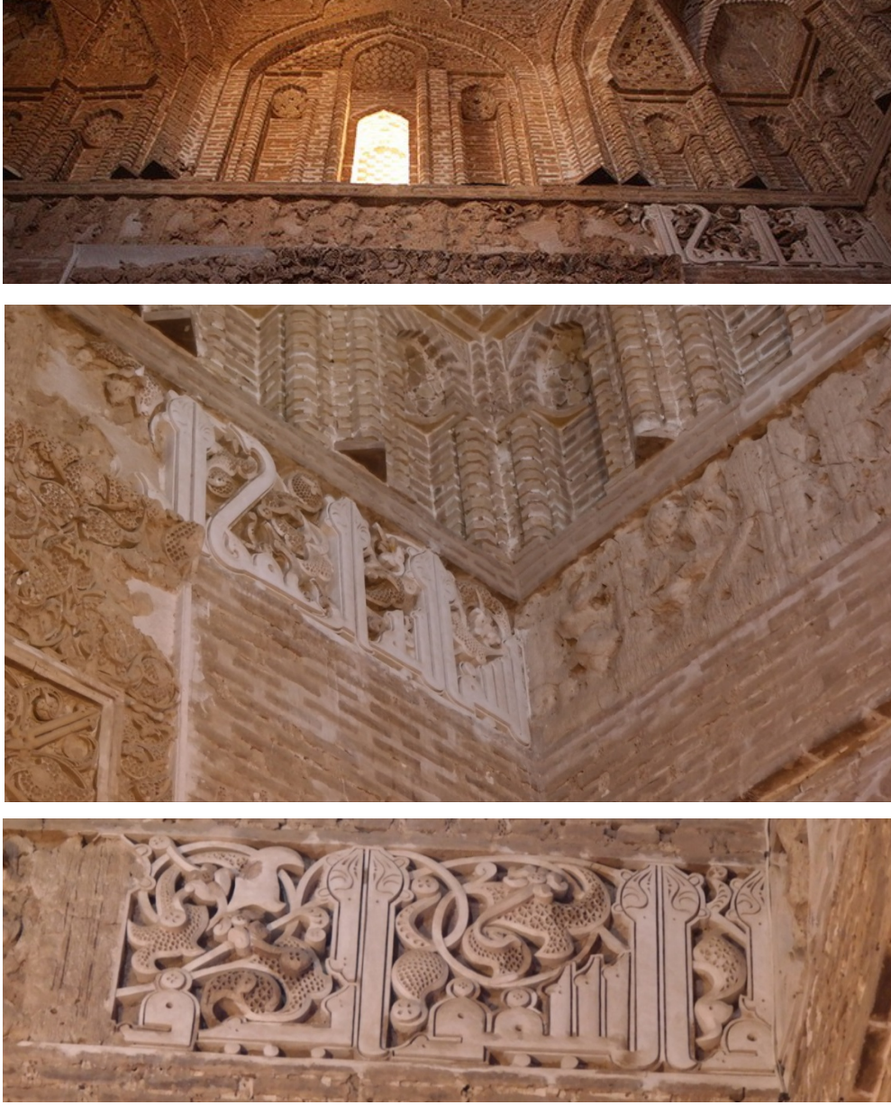
Şekil 17. Zeyvare Cuma Camii Yazı Kuşağından Ayrıntılar
