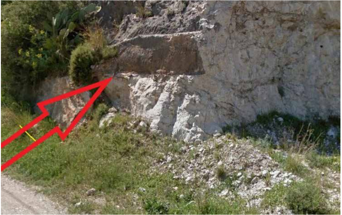
Resim 7: Birinci (Roma) Su Yolu Kalıntısı (Ankara Mahallesi)
