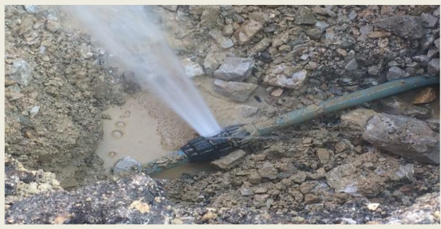
Şekil 7. Tarama sonucu bulunan fiziki su kayıp noktası kazı çalışması sonucu.
