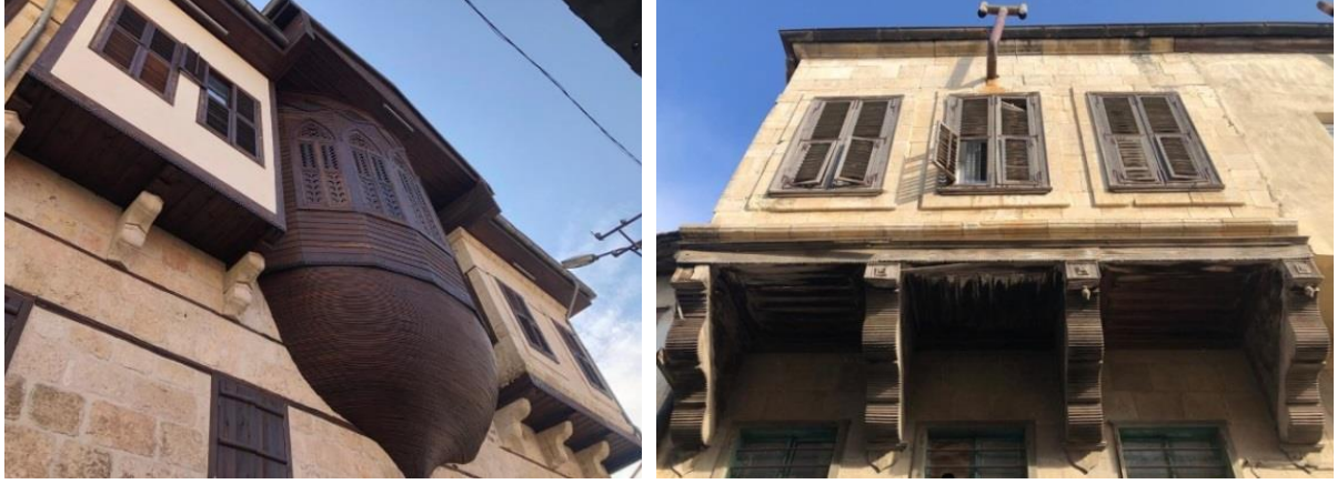
Şekil 8. Geleneksel Tarsus cumba örnekleri
