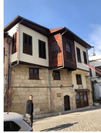
Şekil 11. Geleneksel Tarsus evleri karma sistem
