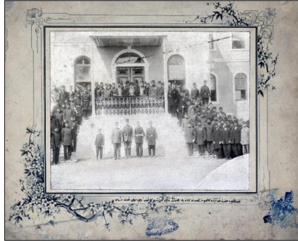
Şekil 12. 19 Ağustos 1320 (1 Eylül 1904) tarihinde açılışı yapılan Gümülcine Livası Hükümet Konağı – Hitabet Balkonu İşlevi Gören Yüksek Giriş Portikosu (Cumhurbaşkanlığı Osmanlı Arşivleri, Kurum: TFR.I..FTG., Yer: 1-40)
