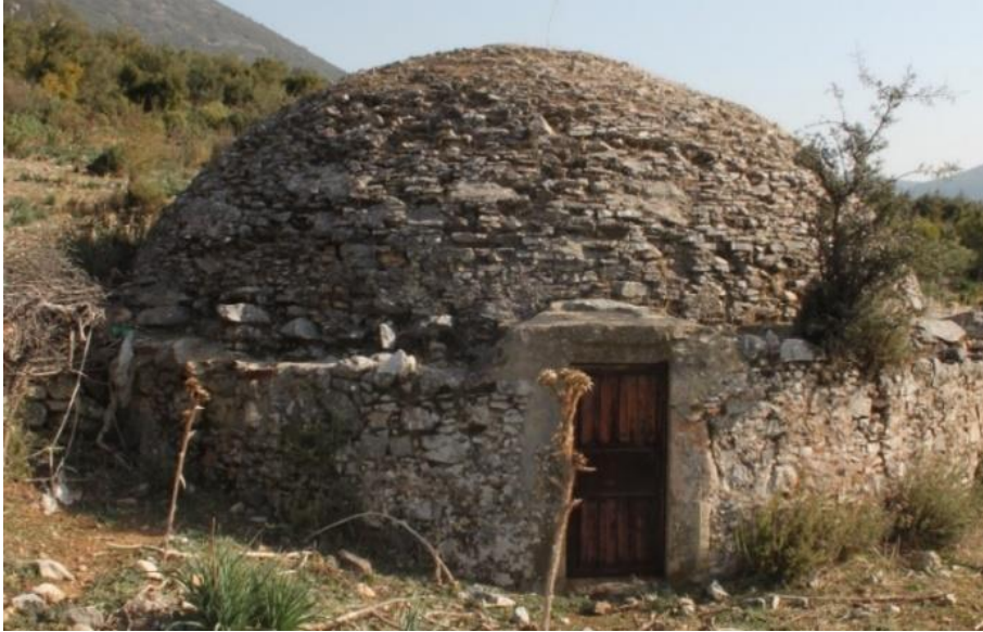
Şekil 5. Küre Kubbeli Kızılcaekin Sarnıcı (Fotoğraf; M.E. Dere)
