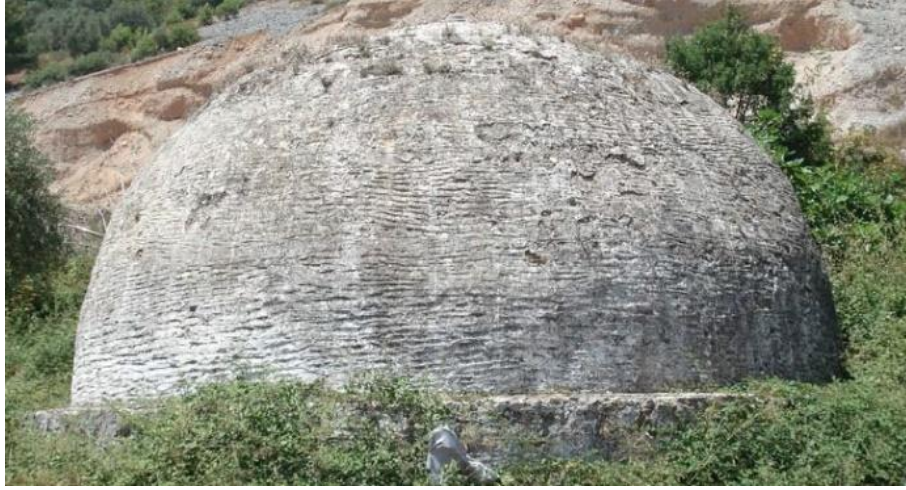
Şekil 6. Yüksek Kubbeli Gökova Sarnıcı (Fotoğraf; M.E. Dere)
