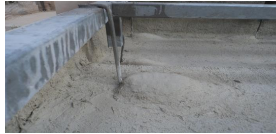
Şekil 1. Pad sayısına göre kullanılacak harcın hazırlanması.
