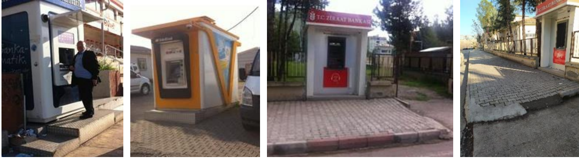
Şekil 17. Şilbe Toplu Konutlarındaki ATM'lerden görünüm
