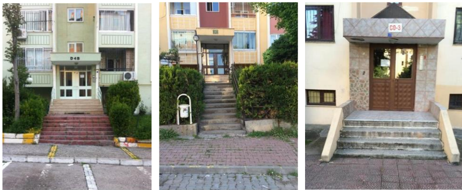
Şekil 27. Şilbe TOKİ yerleşkesinden bina giriş örnekleri
