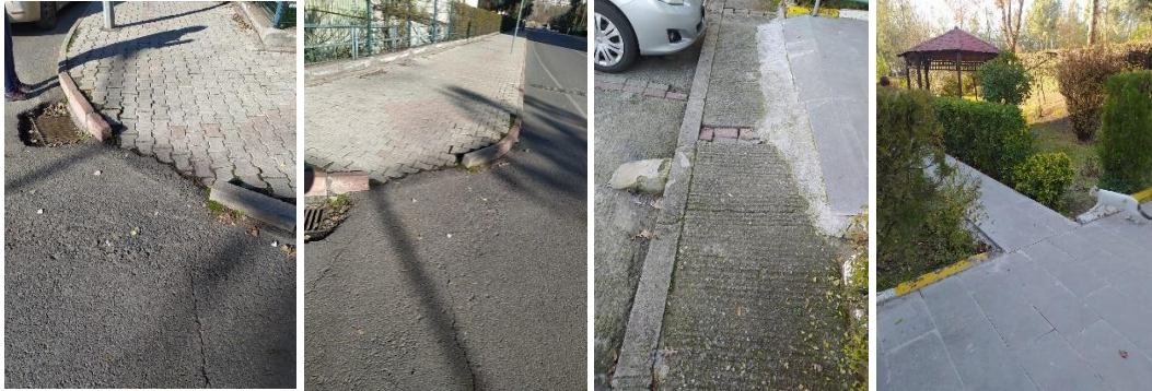
Şekil 12. Şilbe konut yerleşkesinde yürüme yolları ve kaldırımlar
