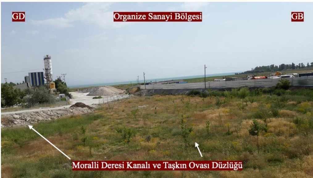
Şekil 4. Organize sanayi bölgesi civarında bulunan Moralli Deresi kanalı ve taşkın ovası düzlüğü.
