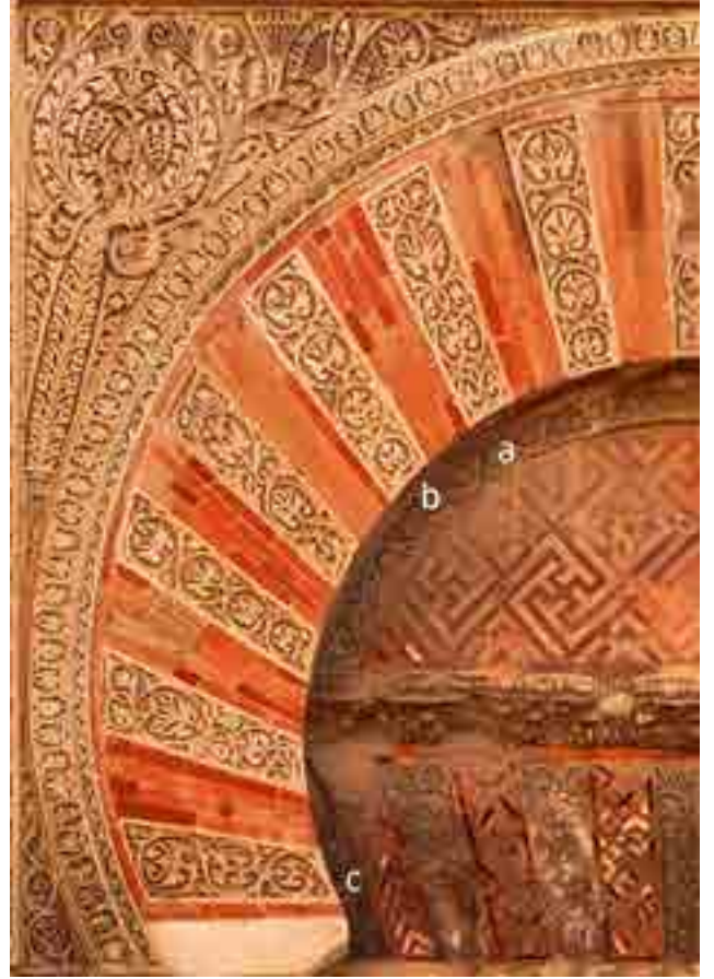
Görsel 8 5 At nalı kemerin alın kısmının ve kemer köşeliğinin detayı.
