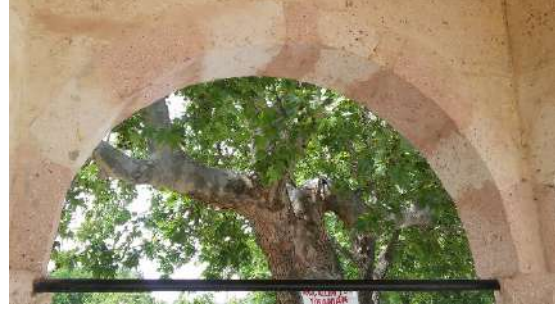
Resim 33. İki renkli taş işçiliği ile yapılmış kemerlerin görünüşü
