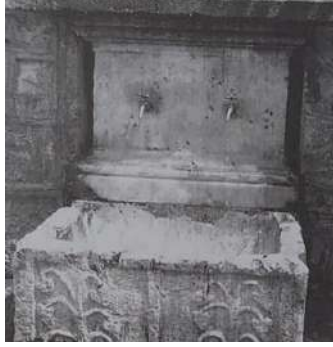
Resim 62. Yıkılan çeşmenin genel görünüşü
