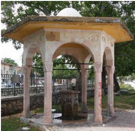
Resim 30. Kepir Pınarı genel görünüşü
