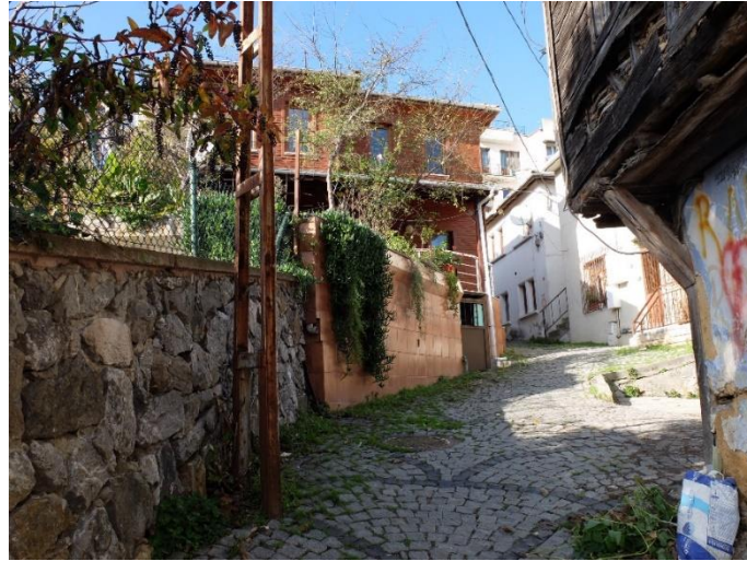
Şekil 9. Camcı Sokak'ta restorasyonla özgün niteliğini kaybetmiş yapı (2021)
