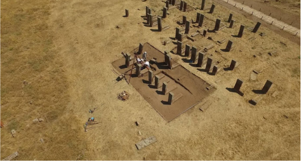
Foto 2: Selçuklu Meydan Mezarlığı restorasyon çalışması.
