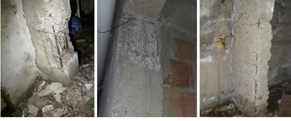
Şekil 13. Donatı ve sargı eksikliği örnekleri.
