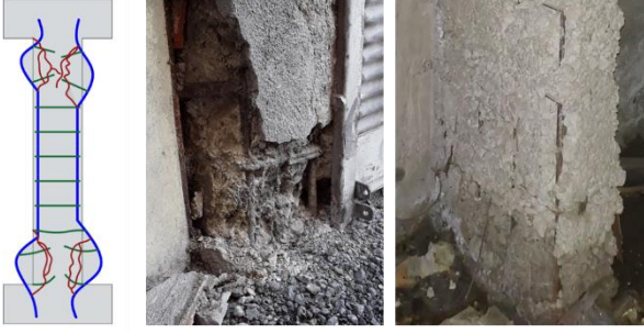
Şekil 6. Çevrimsel eğilme hasarı örnekleri.
