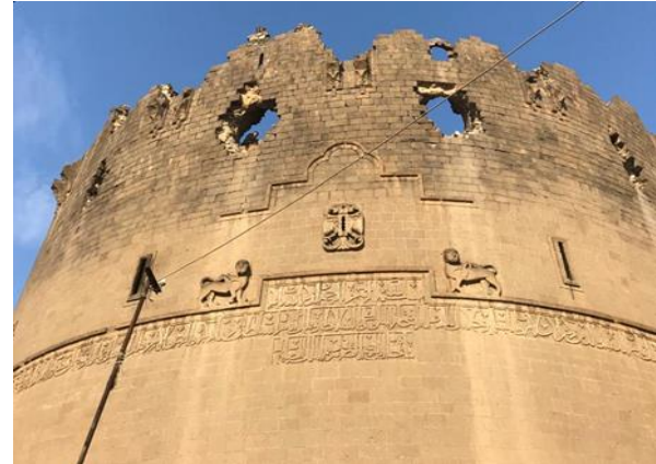
Şekil 2. Yedikardeş Burcu güney cephesi
