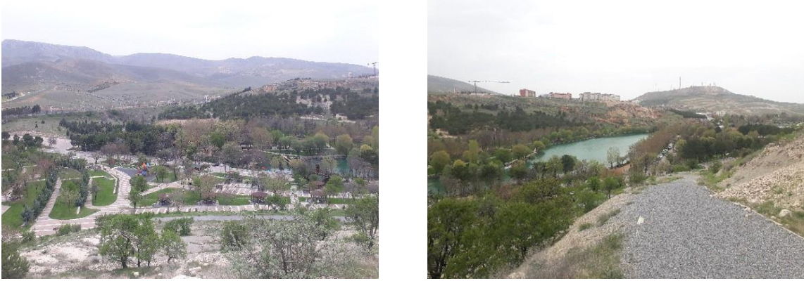
Şekil 6. Çalışma alanının yüzeysel durumu
