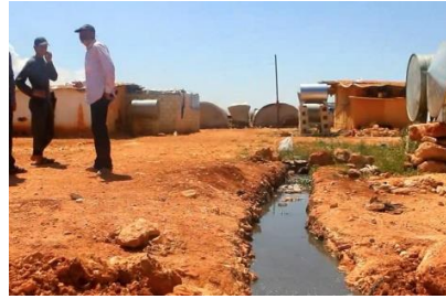
Kanalizasyon sızıntısı (Syria Tv, 2019)
