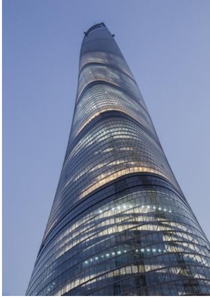
Şekil 5. Shangai Tower dış görünüm (ArchDaily, 2021b)
