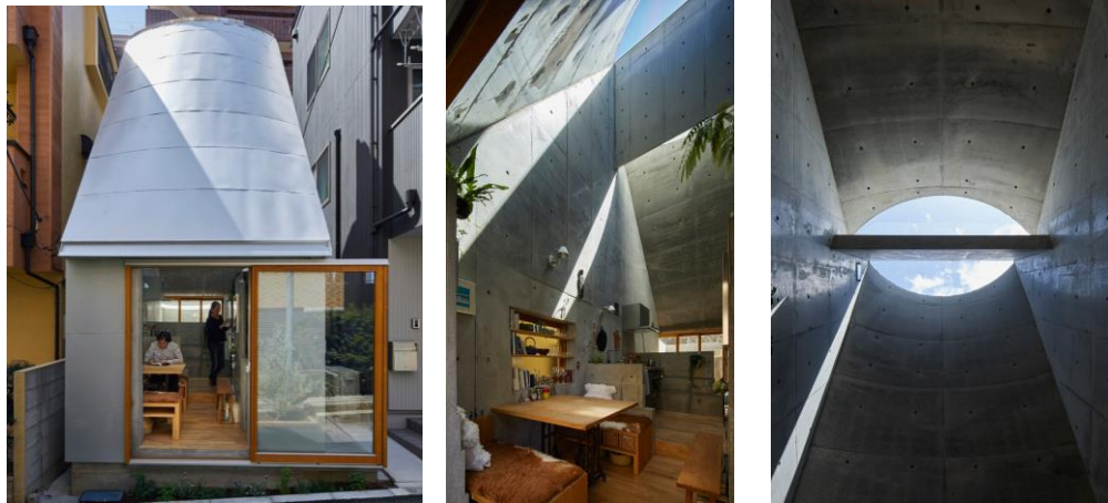
Şekil 5. Takeshi Hosaka tasarımı mikro ev ve çatısı (Takeshi Hosaka Design Tiny House, 2019)
