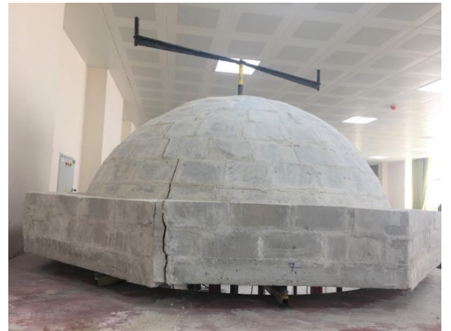
Şekil 5. Referans deney numunenin göçme sonucundaki hali
