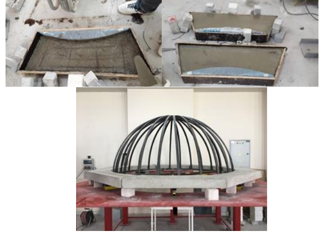
Şekil 2. Kubbe numune örümü için beton blokların üretimi ve yerleştirilmesi
