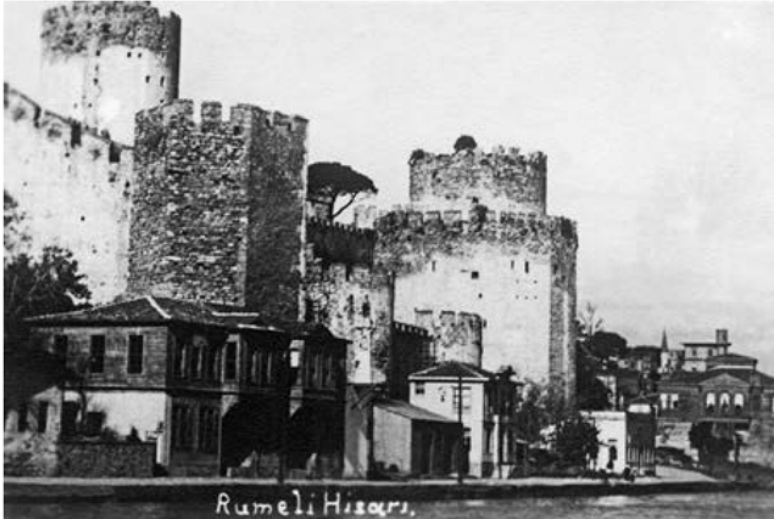
Şekil 6: Durmuş Dede Tekkesi, karakol binası ve Şeytan Akıntısı kıyılarında yer alan yalılar (Göncüoğlu, 2016).
