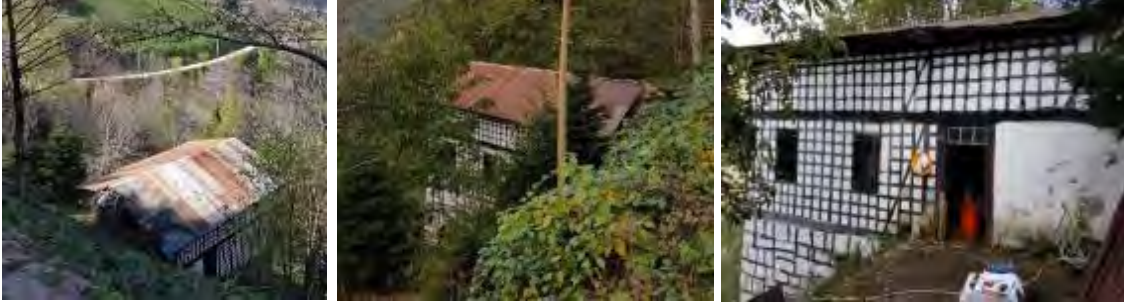
Şekil 11. Güneydeki yol kotundan Asım Ekşi evi
