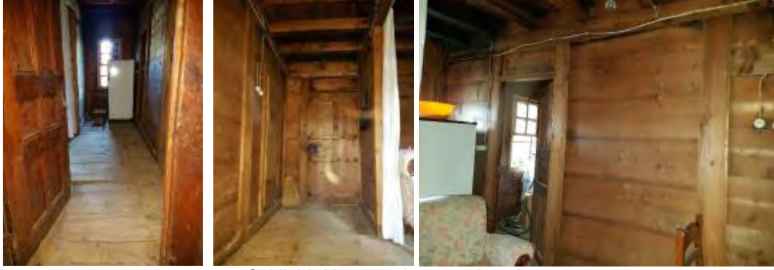
Şekil 14. Hayat mekanının duvarları
