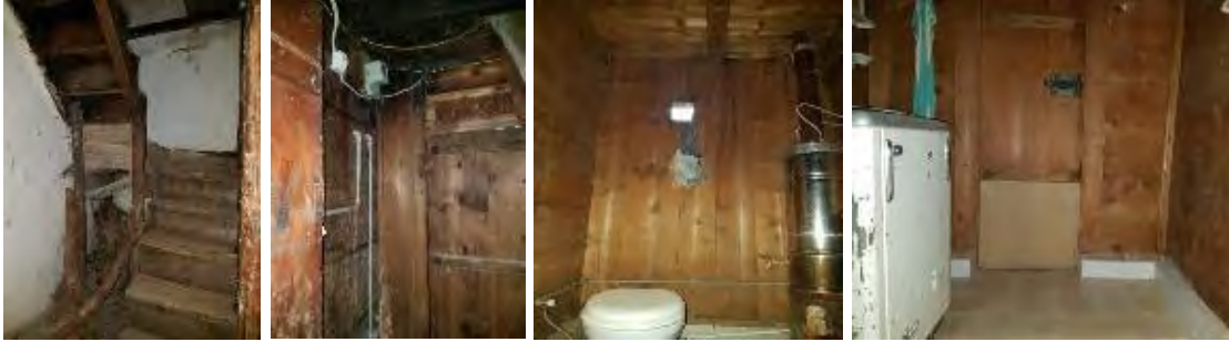
Şekil 13. Çatı katıyla bağlantıyı sağlayan merdiven holü (Sol iki), ıslak hacmin doğu ve batı duvarları
