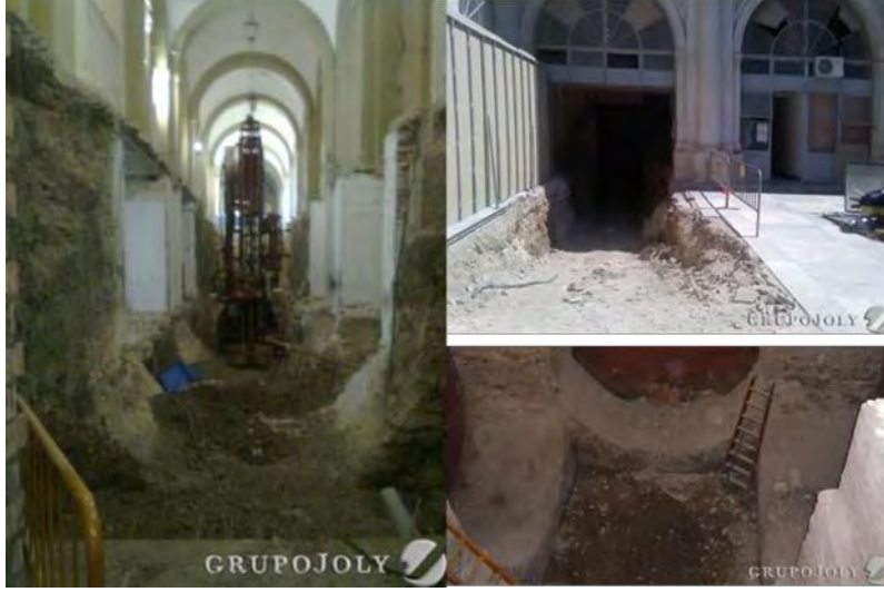
Şekil 17. Yapılan kazılarda ortaya çıkan ve nadir görülen ters kemerli temel (URL-8)
