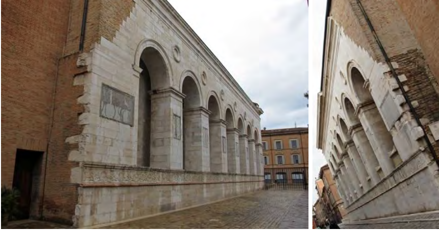
Fotoğraf 11: Eski kilise cephesiyle yeni tapınak cephesinin, yapının kuzeydoğu köşesinde birleşim detayı (URL-25), (URL-26)
