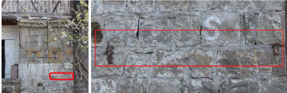
Fotoğraf 16: Taş duvarlardaki demir hatıllar (M. Ataman)
