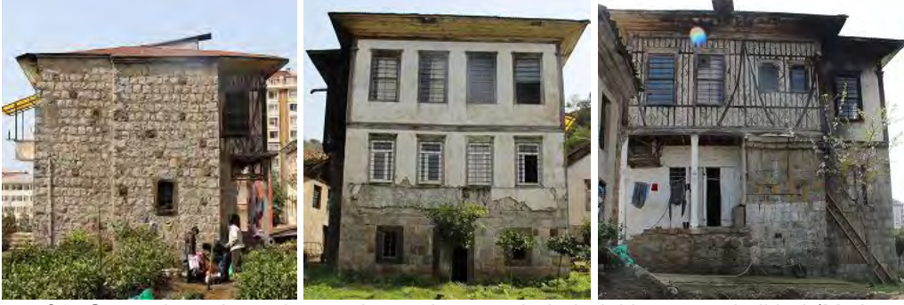
Fotoğraf 3: Güneydoğu, kuzeybatı ve kuzeydoğu cephelerindeki yapım teknikleri (M. Ataman)
