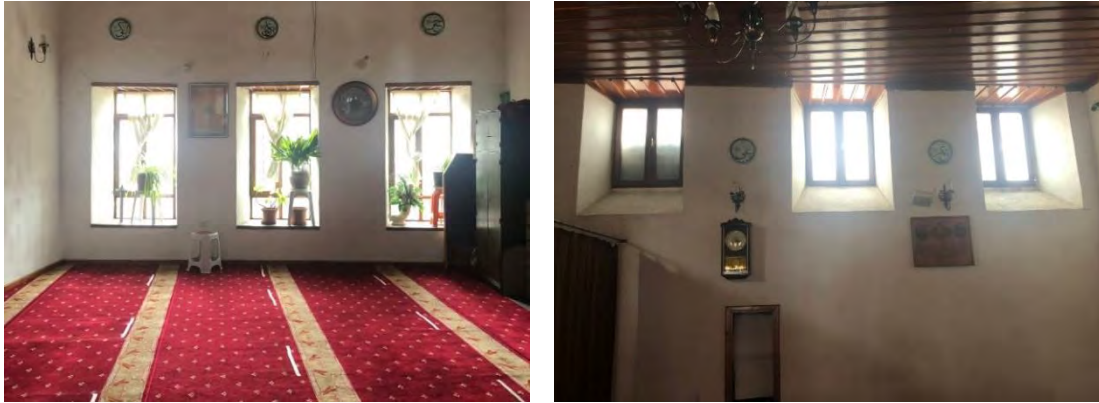
Şekil 8. Batı ve doğu cephesinde yer alan pencereler (Yazar arşivi)
