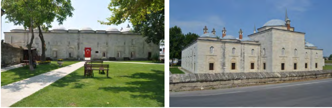
Şekil 11;12. Kuzeydoğu cephesi; Güneybatı cephesi (Benian ve Mısırlı, 2018)
