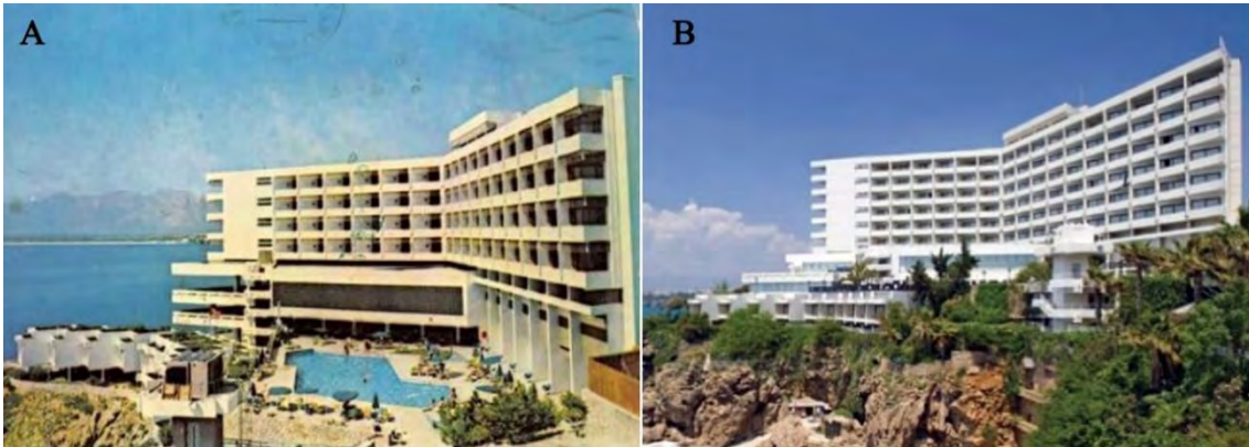
Şekil 2. (A) Talya Otel'i'nin 4 yatak katlı hali, (B) Talya Otel'i'ne iki ek yatak katı daha inşa edildikten sonraki hali (URL-13, 14)
