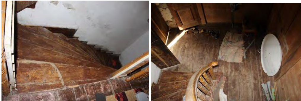
Fotoğraf 9: Ahşap dönerli merdiven (M. Ataman)
