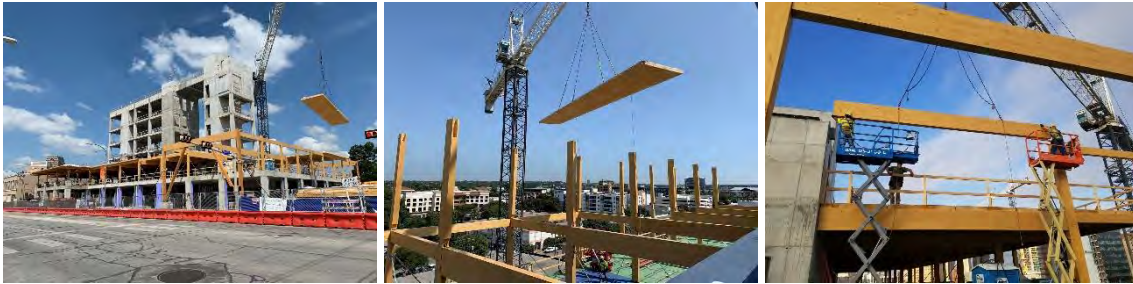
Şekil 3. Prefabrik olarak üretilen ahşap malzemenin montajı (Url 34, 2021)
