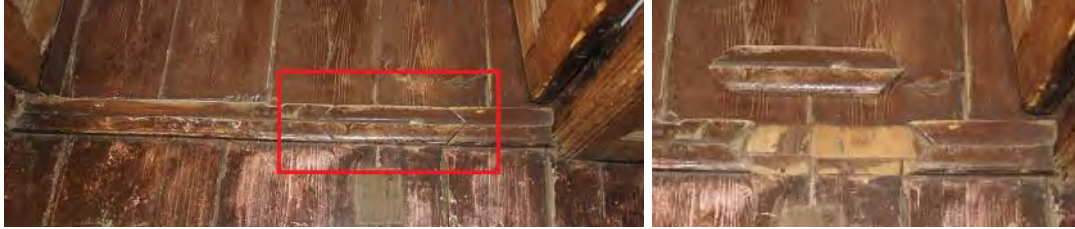
Fotoğraf 8: Kapı eşiklerindeki temizlik için yapılan detay (M. Ataman)
