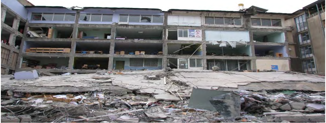
Şekil 26: Depremden Yıkılan İş Yeri Görünüşü (Ş. Öztürk)
