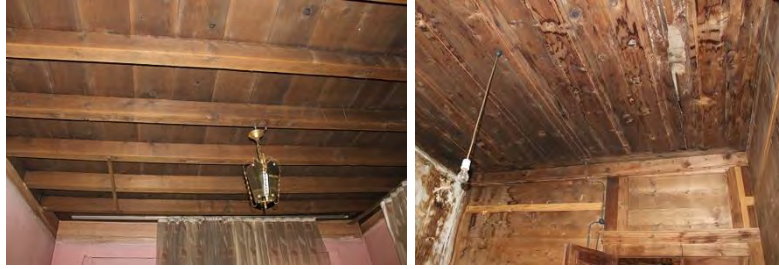
Fotoğraf 4: Ahşap hatıllı ve binili tavan (M. Ataman)
