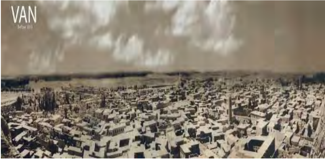
Şekil 1: 1918 öncesi Eski Van Şehri Genel Görünüşü (Anonim)
