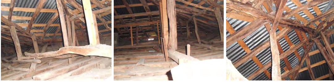
Fotoğraf 11: Ahşap oturtma çatı düzeni (M. Ataman)
