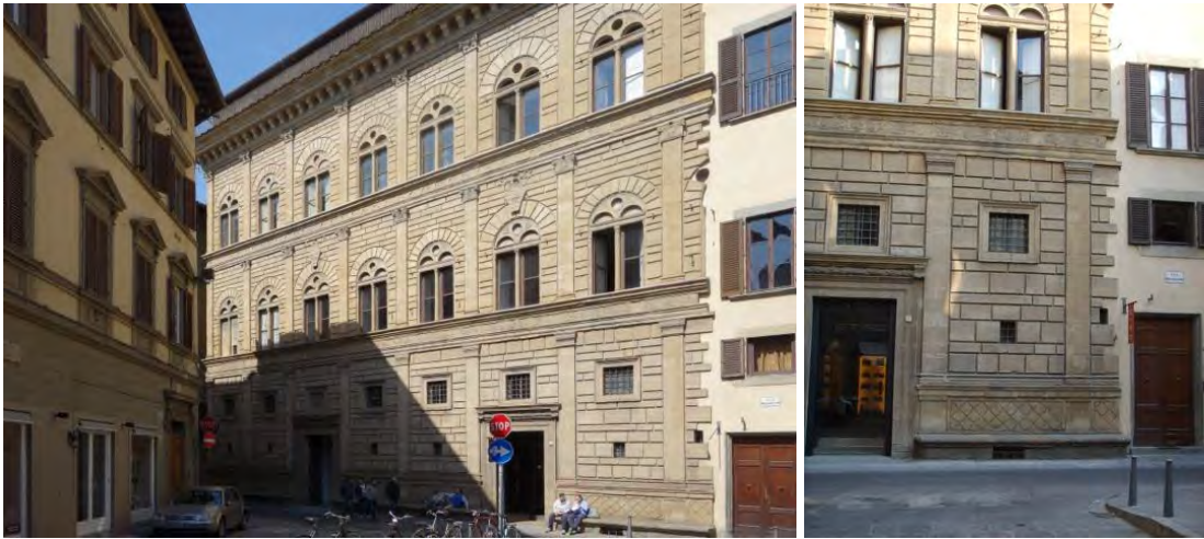
Fotoğraf 4: Cephenin tamamlanmamış izlenimi uyandıran ve yandaki yapıya çıkıntılar yapan güneydoğu kenar detayı (URL-9), (URL-10)
