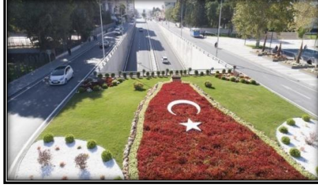
Şekil 8. Musa Şahin Bulvarı Üzerinde Yapılan Devlet Bahçeli Alt Geçidinden Bir Görünüş (Anonim-23, 2019)
