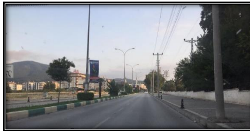
Şekil 25. Kazım Tülücü Bulvarı'nın Eğimli Olan Bölümünden Bir Görünüş (Orijinal 2019)
