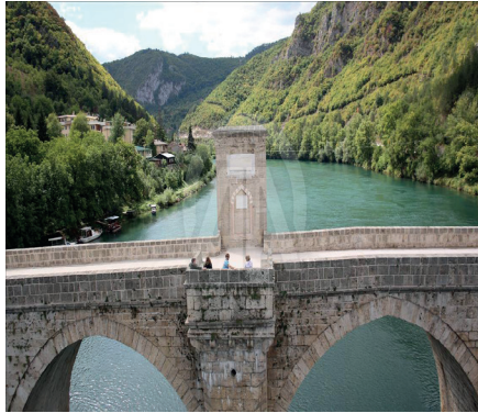
Şekil 3.2: Köprü'nün merkezinde Kapiya, sofa ve Taş Duvar. "Mimar Sinan'ın Bosna Hersek'teki imzası Drina Köprüsü". (2018). erişim adresi: https://www.milligazete.com.tr/haber/1496539/mimar-sinanin-bosna-hersekteki-imzasi-drina-koprusu
