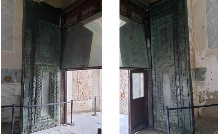
Görsel 30. Güzel Kapı iç görünümünden sağ ve sol kanatlar.
