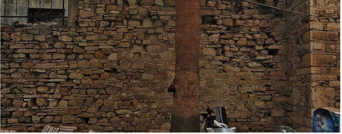
Şekil 17. Kuşadası Şehir Surları kuzeydoğu hattından duvar işçiliği ve derz detayı.
