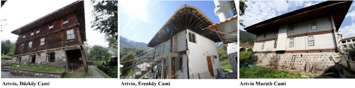
Şekil 6. Artvin’de ahşap yığma cami örnekleri (DOKAP, 2019).
