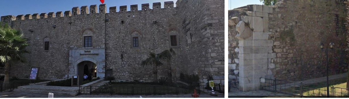
Şekil 12-13. Öküz Mehmed Paşa Kervansarayı ön cephesi ve bu yapıya kuzeyden bitişen kent kapısı kalıntısı.
