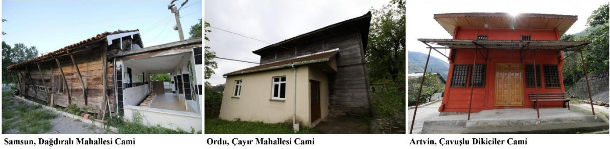
Şekil 8. Ahşap yiğma sistemi camilerde kullanım sürecindeki müdahaleler, muhdes ek (DOKAP, 2019).
