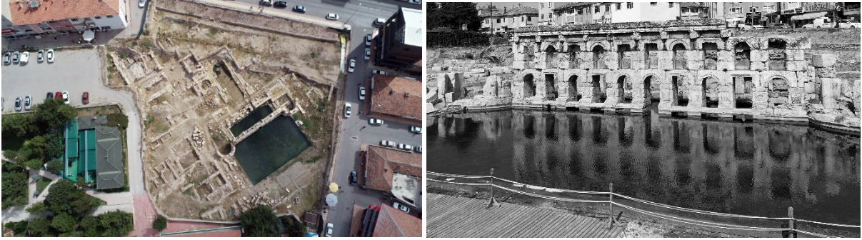
Görsel 12. Sarıkaya Roma Hamamı Hava Fotoğrafı ve on açıklıklı batı cephesi.
