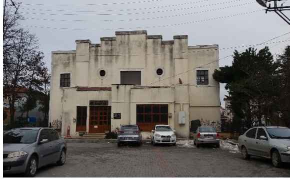
Görsel 3. Eski Kilise Mevcut Görünümü.
