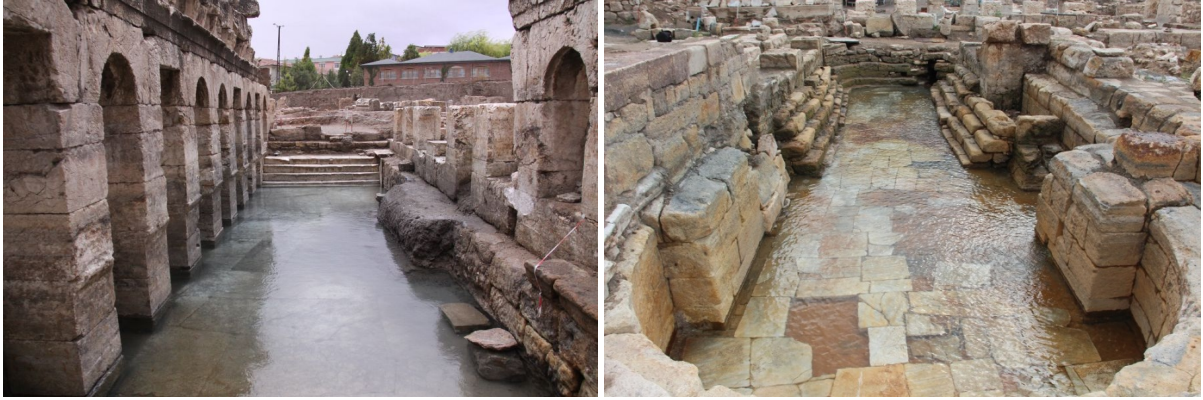
Görsel 18. Doğu ve Batı Kemerleri arasında kalan dikdörtgen formulu ikinci havuz (solda) ve yarım daire formulu üçüncü havuz (sağda).
