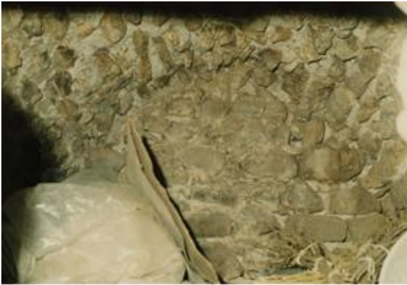
Şekil 12: Kapıları avluya açılan odalar 2
