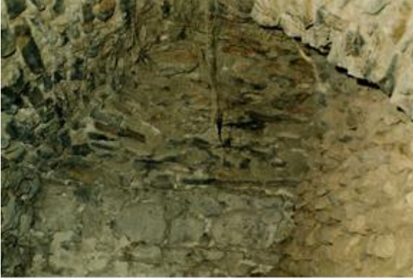
Şekil 11: Kapıları avluya açılan odalar 1
