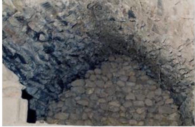
Şekil 8: Avlunun kuzeyindeki eyvan
