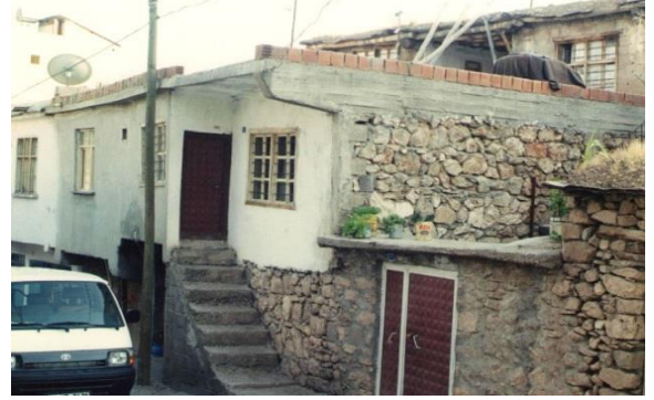
Şekil 3: Hanın genel görünüşü ve kuzey duvarı
