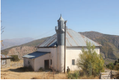
Foto 2: Batı cepheden görünüş
