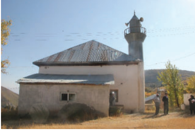
Foto 1: Kuzey cepheden görünüş
