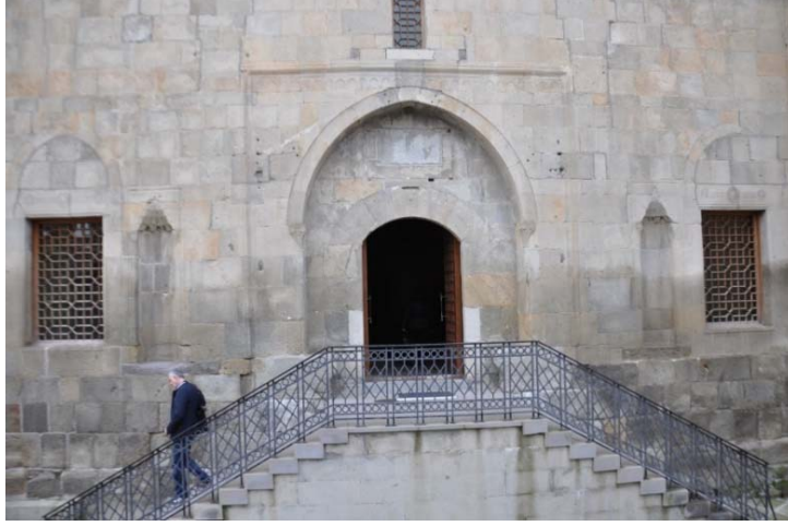
Fotoğraf 5: Ahmediye Cami Cümle Kapısı, Restorasyon Sonrası, (Aytekin, 2014)
