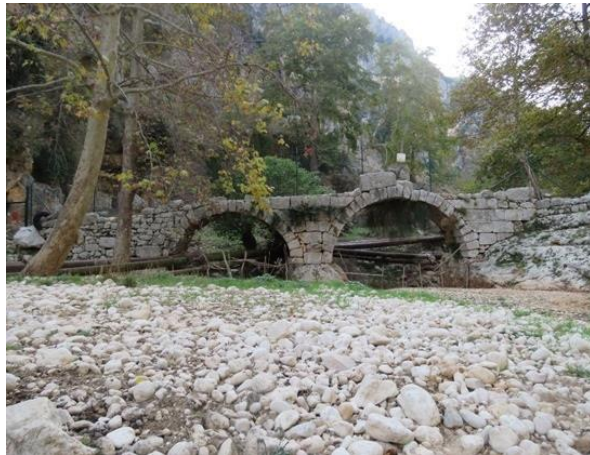
Fig. 4. Yeniyurt Köprüsü'nün memba cephesi
