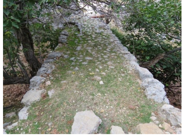
Fig. 13. Köprü tabliyesinin güneyden görünümü
