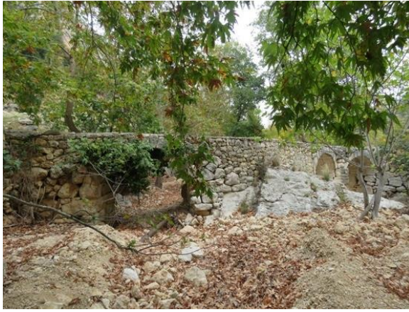
Fig. 7. Eşek Köprüsü'nün memba cephesi
