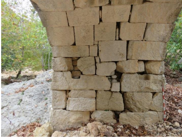
Fig. 9. Tonz içi ve hatıl deliklerinden ayrıntı
