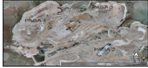
Şekil 17. Üretim alanı çevresindeki pasa sahalarnın görünümü
