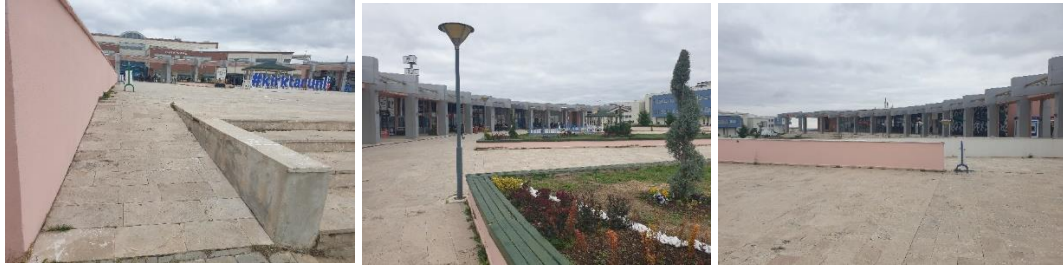
Şekil 7. Sosyal yaşam alanı dersliklerden giriş rampası ve kuzey-güney alanlarından görüntüler
