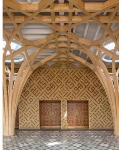
Şekil 18. Cami içerisinde kullanılan ahşap yelpaze tonoz sistem (URL 12)
