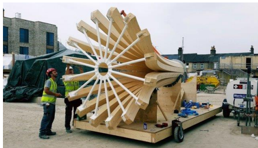
Şekil 15. Camide kullanılan glulam kolon (URL 12)
