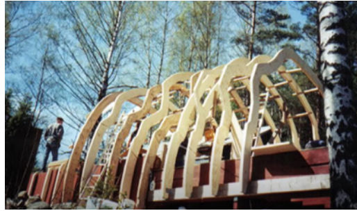
Şekil 13. Yapının ahşap strüktürü (URL 7)
