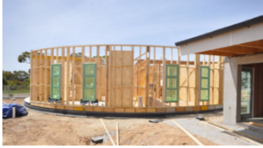
Şekil 19. Yapının ahşap strüktürü (URL 11)
