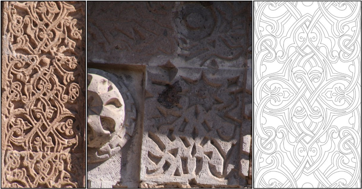
Görsel 10 A-Taşkınpaşa Hanıgahı Taçkapısının Dıştan Üçüncü Bordürün Özgün Durumu B-Restore Edilmiş Bordürün Durumu C-Bordürün Model Çizimi
