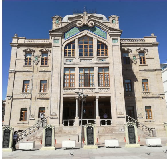
Foto 1: Aksaray Hükümet Konağı Doğu Cephesi Görünüşü
