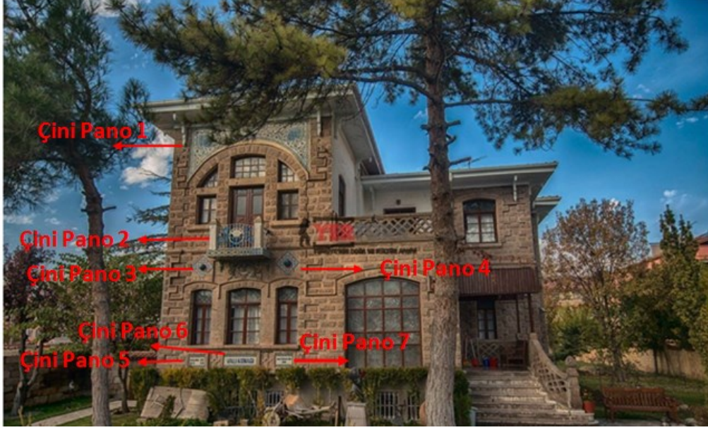
Foto 24: Yapının Doğu Cephesi (ön cephesi) ve Çini Panolarının Gösterimi
