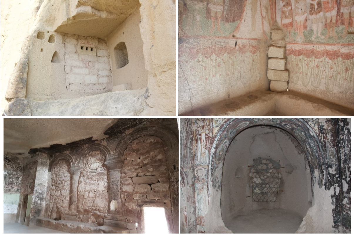
Fotoğraf 8. Stabilitiyi Sağlamak için Kaya Bloklarının Kullanımı
