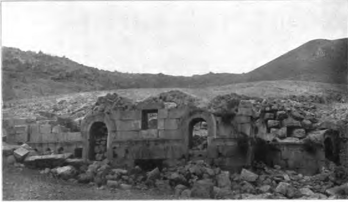
Şekil 6. Panagia Kilisesi (Rott, 1908)
