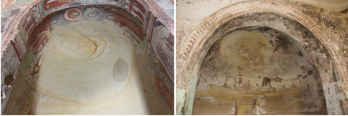
Fotoğraf 11. Nem Kaynaklı Taşlarda Oksidasyon ve Renk Değişimleri
