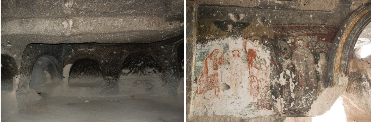
Fotoğraf 10a. Dış ve İç Duvar Yüzeylerinde Mikrobiyolojik Oluşumlar ve Renk Değişimi
