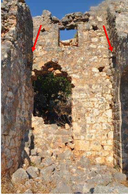
Resim 14: Sura Vadi Kilisesi, kuzey nef dođu duvarı, batıdan görünüm, kuzey duvar ve duvar payesi yan yüzeyinde bulunan hatıl yuvaları
