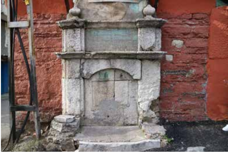
F. 14: Salih Ağa Çeşmesi ana cephesi (Tunçez, 2018)
