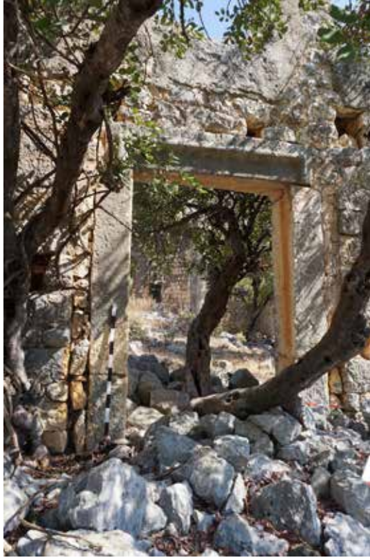
Resim 10: Sura Vadi Kilisesi, narteks dođu duvarı, orta nef giriř kapısı, hatıl yuvaları ve kat/üst örtü ayırımı
