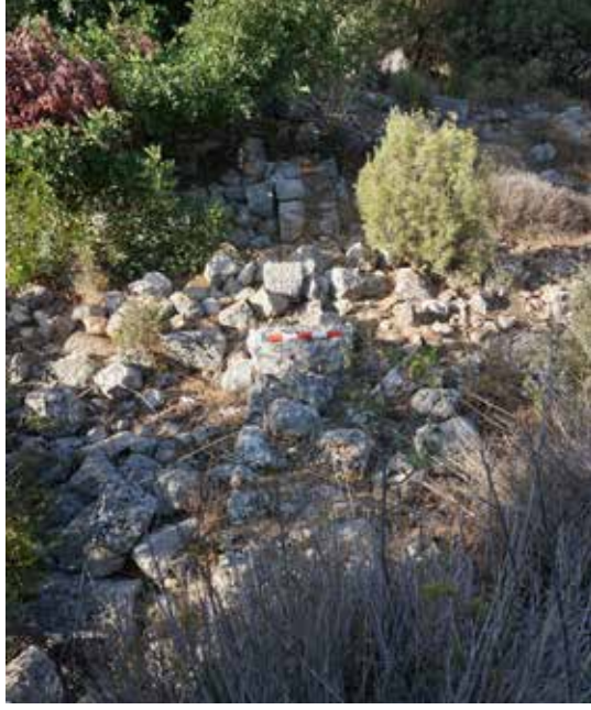
Resim 5: Sura Şehir Kilisesi, 1 Numaralı Kilise güney nef ayırımı ve 2 Numaralı Kilise güney duvarı, doğudan görünüm
