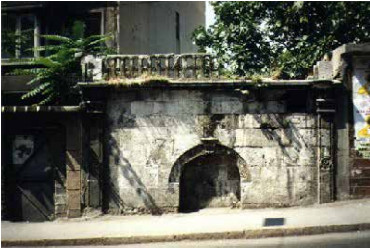
F. 6: Paşa Baba Çeşmesi'nin restorasyon öncesi görünümü (Su Vakfı)
