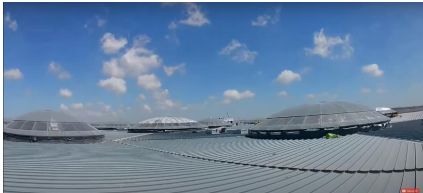
Şekil 1. İstanbul Havalimanı'nın çatısından bir görünüm
