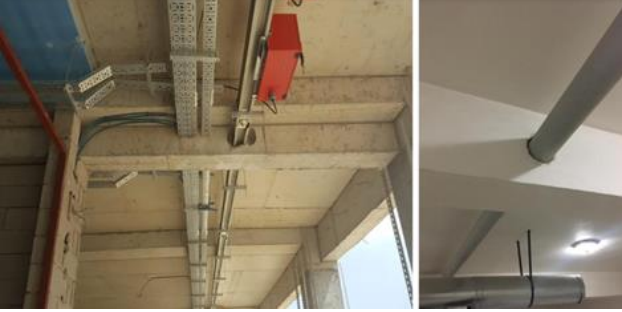
Şekil 1. Kirişte sonradan açılan boşluklar [1]
