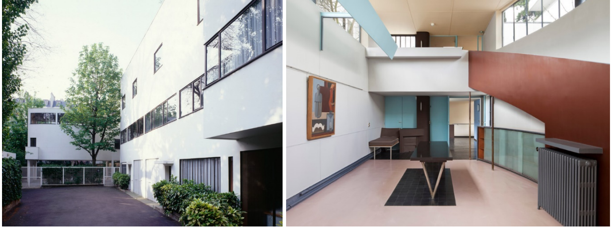
Şekil 3. La Roche - Jeanneret Evi dış mekân ve iç mekândan bir görünüm (Lecorbusier-worldheritage, 2021b)
