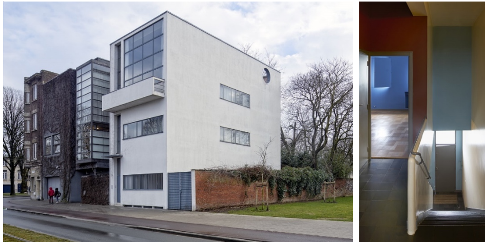
Şekil 7. Guiette Evi, dış mekân ve iç mekândan bir görünüm (Lecorbusier-worldheritage, 2021d)
