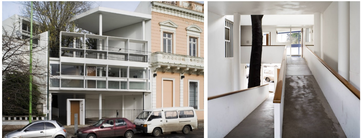
Şekil 11. Cruchet Evi'nden görünüm (Fondation le corbusier, 2021)
