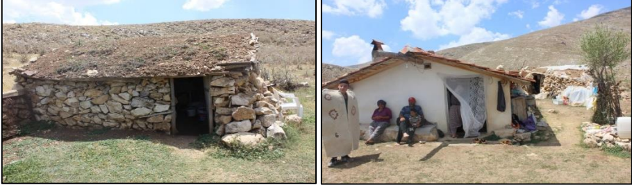
Fotoğraf 3. a) Yığma taş toprak çatılı dam b) Betonarme kiremit çatılı dam
