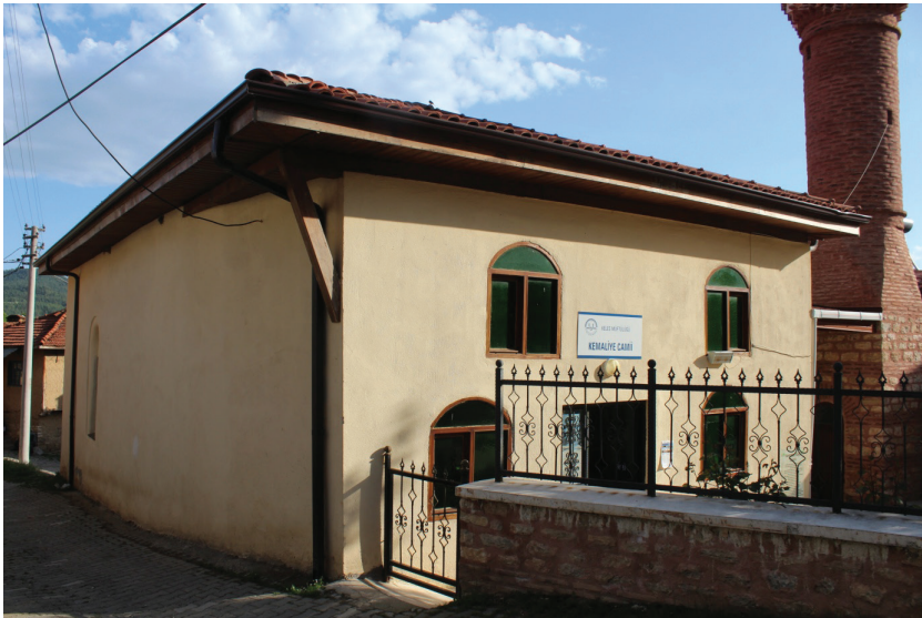
G. 2: Keles Kemaliye Köyü Camii, kuzey ve doğu cephesi (Algaç, 2019)
