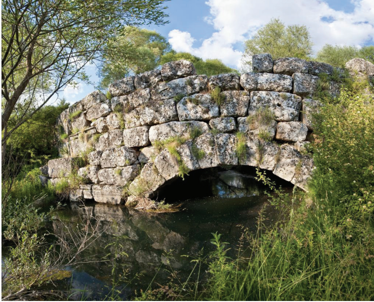
G. 3: Aizanoi Barajı/Sel Kapanı Mansap Duvarı (Aizanoi Kazı Arşivi, 2011-2020).
