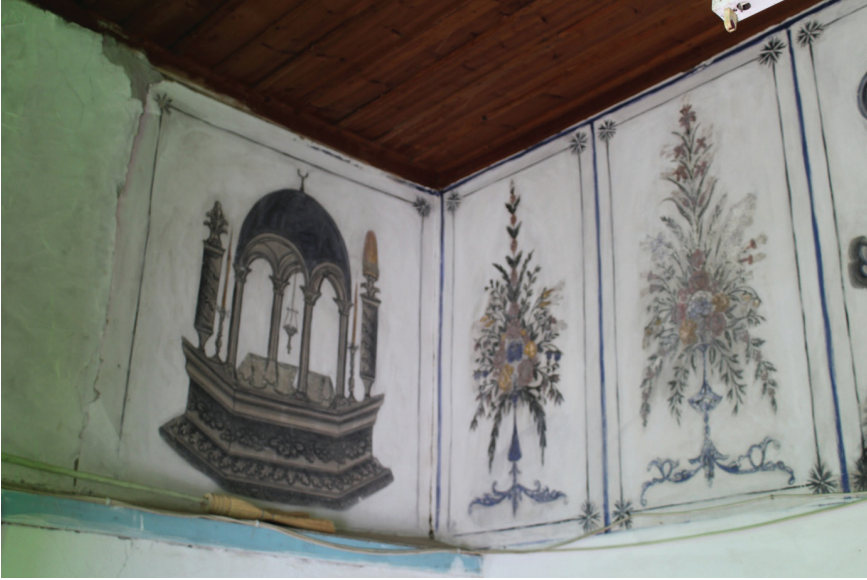
G. 13: Keles Kemaliye Köyü Camii, son cemaat yeri, güney- doğu köşesi (Algaç, 2019)
