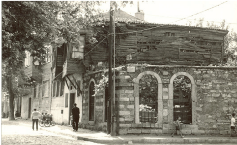
G. 24: Türbe ile selamlık ve harem dairelerinin yer aldığı ahşap yapı (Selda Baltacı Mimarlık Atölyesi Arşivi).
