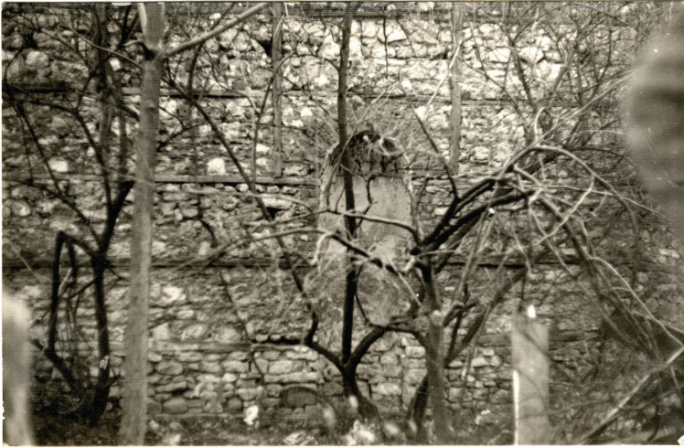
G. 21: Mescid-Tevhidhanenin mihrap duvarının çökmeden önceki görünümü. Tuğladan yuvarlak kemerli ve moloz taş örgü yarım daire şeklinde mihrap nişinin görünümü. (İ. H. Konyalı Arşivi).
