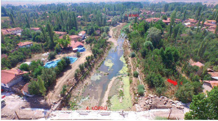
G. 7: Aizanoi Antik Kenti Penkalas Nehri ve Set Duvarları Restorasyon Öncesi (Aizanoi Kazı Arşivi, 2011-2020).
