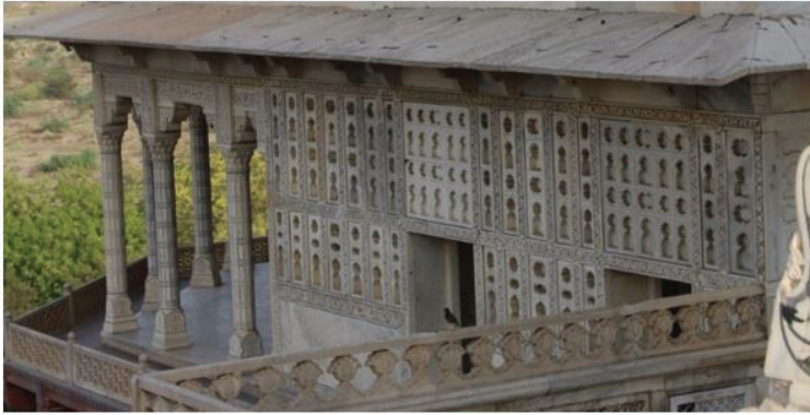
G.16: Müsemmen Burç Dış Cephe Genel Görünüşü (Özler-Kaya, 2016).
