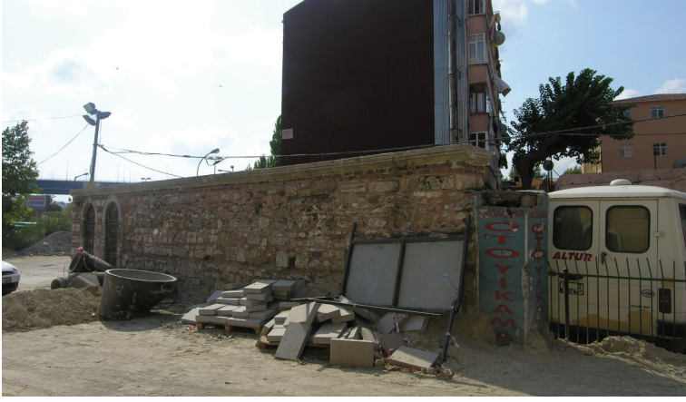
G. 11: Türbenin ve bitiřiğindeki meşid-tevhidhane duvarının batıdan görünüřü (Müfid Yüksel, 2006).
