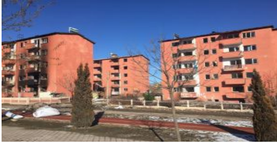
Şekil 6. Karşıyaka Mahallesi Yıkılmayı Bekleyen Binalar (Elazığ Belediyesi, 2021).
