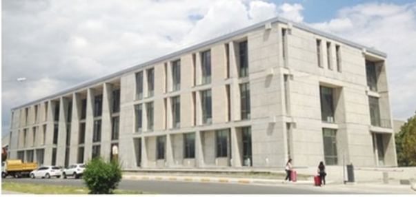
c. Kuzeybatı ve güneybatı cephesi
