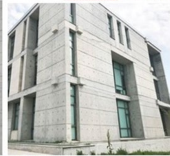
d. Kuzeybatı ve Güneydoğu Cephesi
