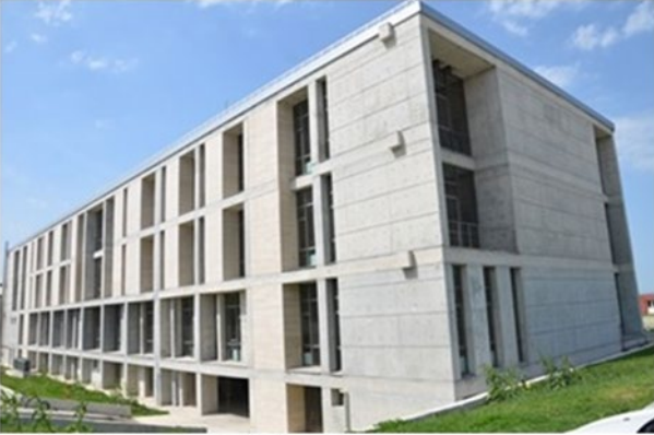
a. Güneydoğu ve Kuzeydoğu Cephesi
