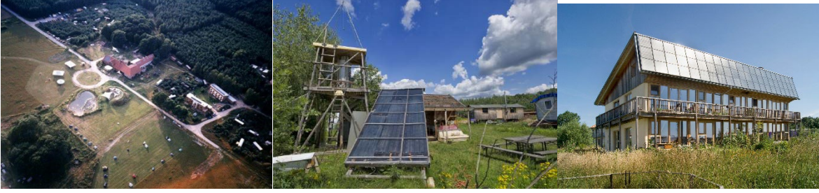
Şekil 16,17,18. Sieben Linden Ekoköyü Fotovoltaik Panellerinin Kullanım Alanları ( http://www.ecovillagenews.org/wiki/index.php/What_We_Can_Learn_from_Ecovillage_Sieben_Linden ) ( https://www.imago-images.de/search?suchtext=Oekodorf%20Sieben%20Linden ) ( https://siedlungen.eu/galerien/fotogalerie-2016-oekodorf-sieben-linden/sony-dsc-3 )
