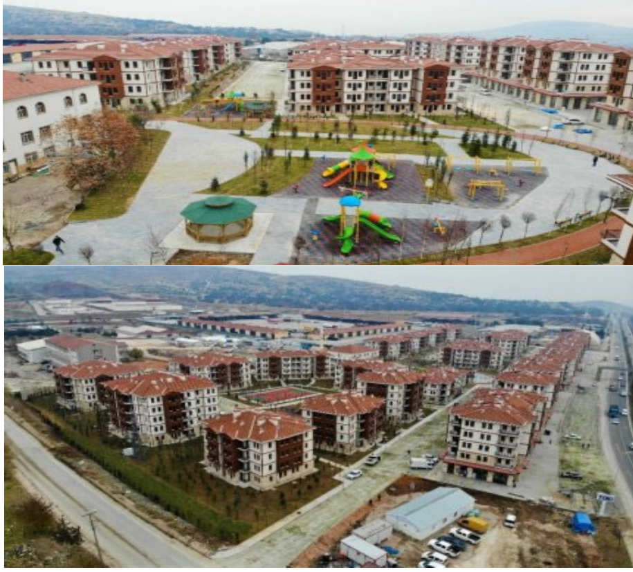
Şekil 8. Kentsel Dönüşüm Projesi Sonrasında Karşıyaka Mahallesi (Elazığ Belediyesi, 2021).
