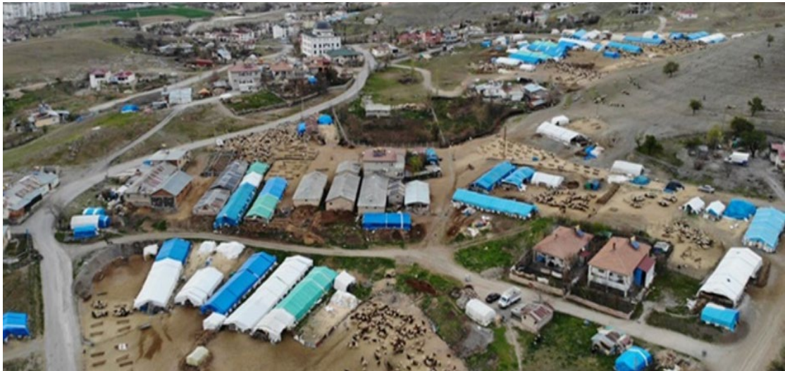
Şekil 7. Dönüşümden Önce Karşıyaka Mahallesi Genel Görünüm (Elazığ Belediyesi, 2021).
