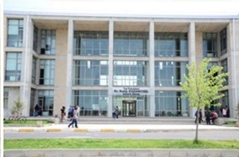
g. Kuzeybatı Cephesi Giriş Arkadı
