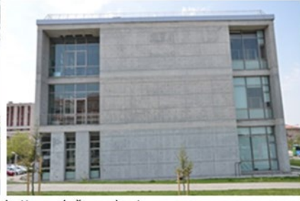
b. Kuzeydoğu cephesi
