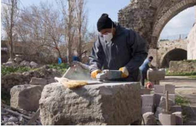
Fotoğraf 7. Çırakların, arkalarında bulunan destek payandasının restorasyonu için hazırladıkları kemer taşları, 2020 (Pergamon Kazı Arşivi). / Ashlar blocks prepared by the apprentices, for the restoration of buttresses, 2020 (Pergamon Excavation Archive).
