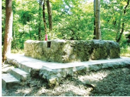
Gah'taki Yünus Emre ve Tapduk Emre makamının yakından görünüşü. Makamın çevresindeki yapı Ağustos 2010'da inşa edilmiş. Duvarlar ise eski.
