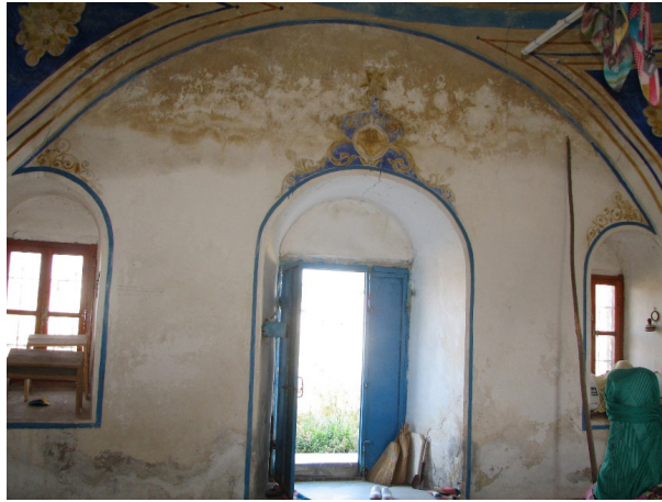
Fotoğraf 7. Seydisül Türbesi. Kuzey Cephe.
