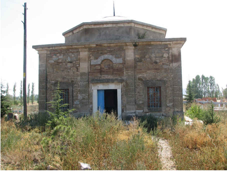
Fotoğraf 3. Seydisül Türbesi. Kuzey Cephe.
