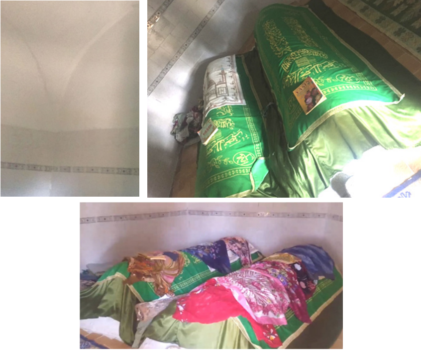
Fotoğraf 13-15: Karaca Ahmet Sultan Türbesi. Kubbe Geçiş Unsurlarından Detay ve Türbedeki Sandukalar (2020).
