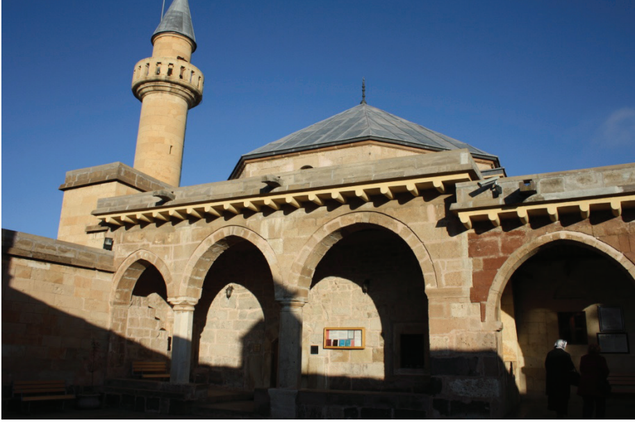
Fotoğraf 10: Hacı Bektaş-ı Veli Tekkesi Camisi, Giriş Cephesi
